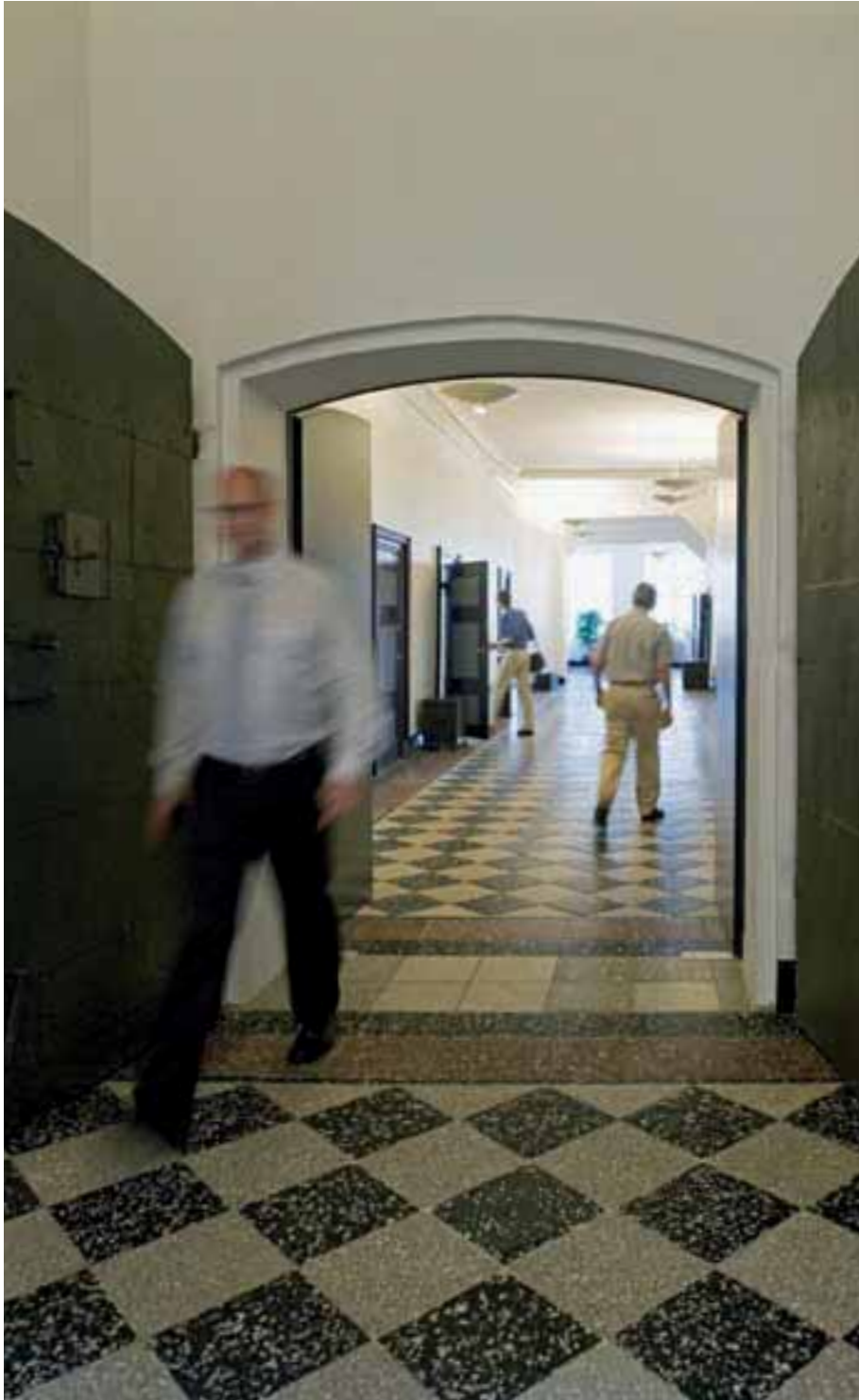
Stengangen, der er 61 meter lang og over 4 meter høj, strækker sig gennem hele 1. sal. Jerndørene er opsat som brandsikring efter Christiansborgs brand i 1794.
